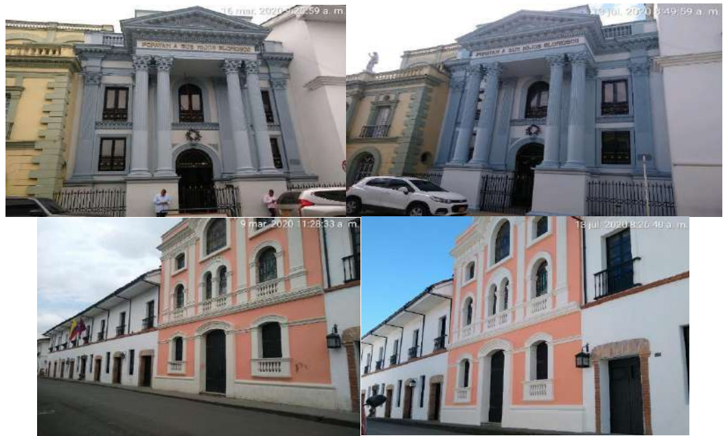
EDIFICIO DIVISION ADMINISTRATIVA Y DE SERVICIOS
