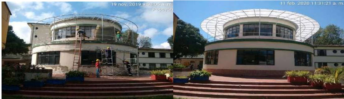
RECTORIA EDIFICIO SANTO DOMINGO
